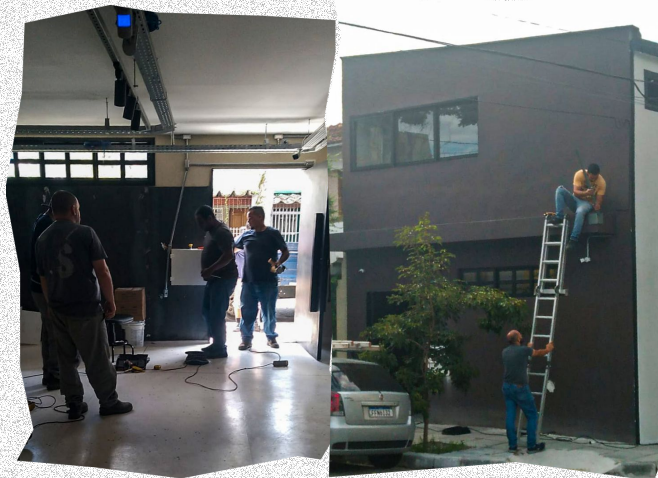
Casa em reforma. Foto: Antonicelmo Carneiro
